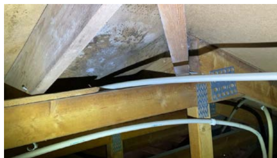
Eksempel på skjolde i undertak ved valm
