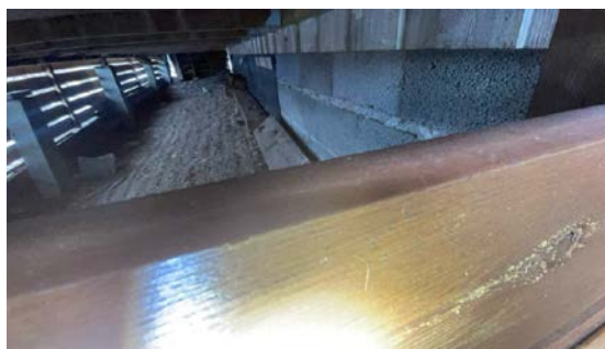
Fuktsperre over terreng under veranda stopper ca. midt på.
