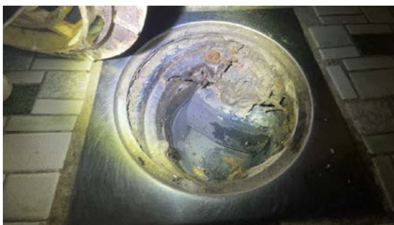
Skadet sluk/klemring
