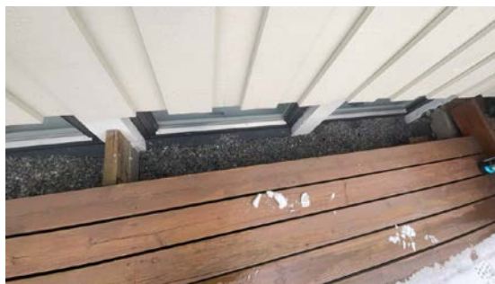
Vinduer lavt i terreng ved terrasse
