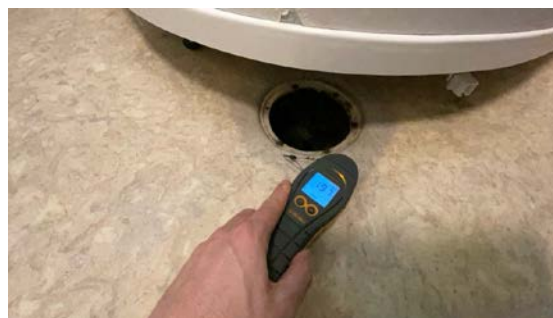
Fuktsøk rundt sluk
