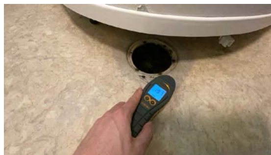
Fuktsøk rundt sluk
