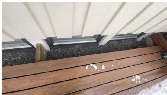
Vinduer lavt i terreng ved terrasse
