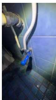
Utett rørgjennomføring for servant (våtzone)
