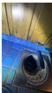
Utett rørgjennomføring for servant (våtzone)
