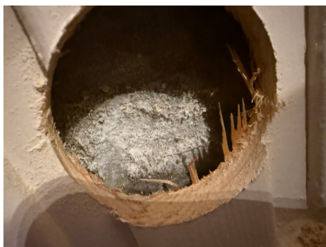
Hulltaking i tilstøtende vegg
