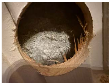
Hulltaking i tilstøtende vegg
