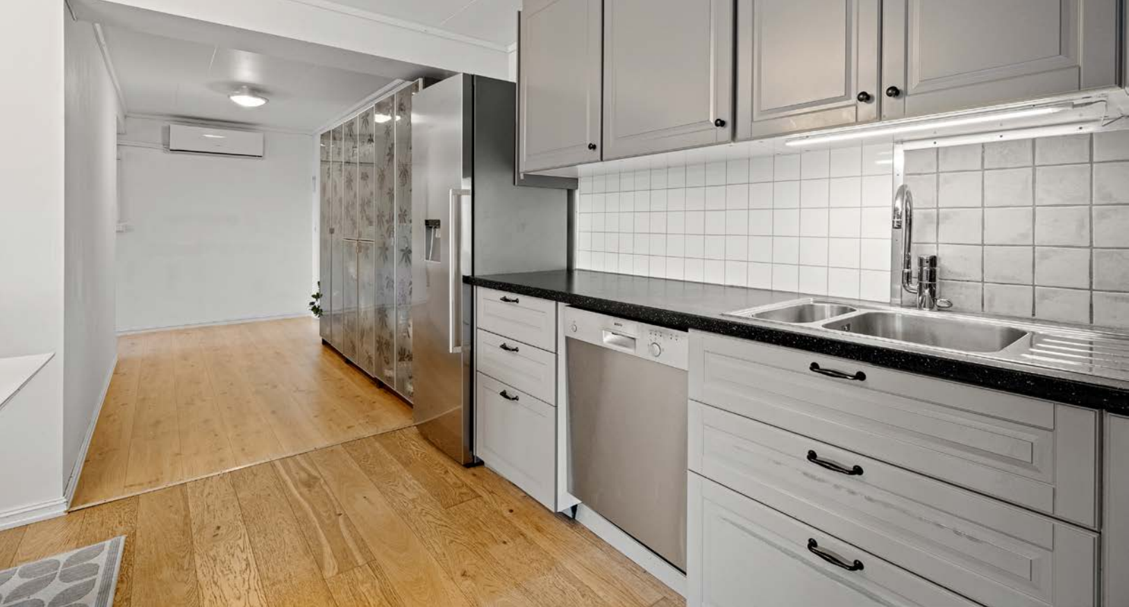
Leiligheten har montert varmepumpe i gang.
