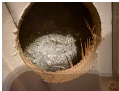
Hulltaking i tilstøtende vegg
