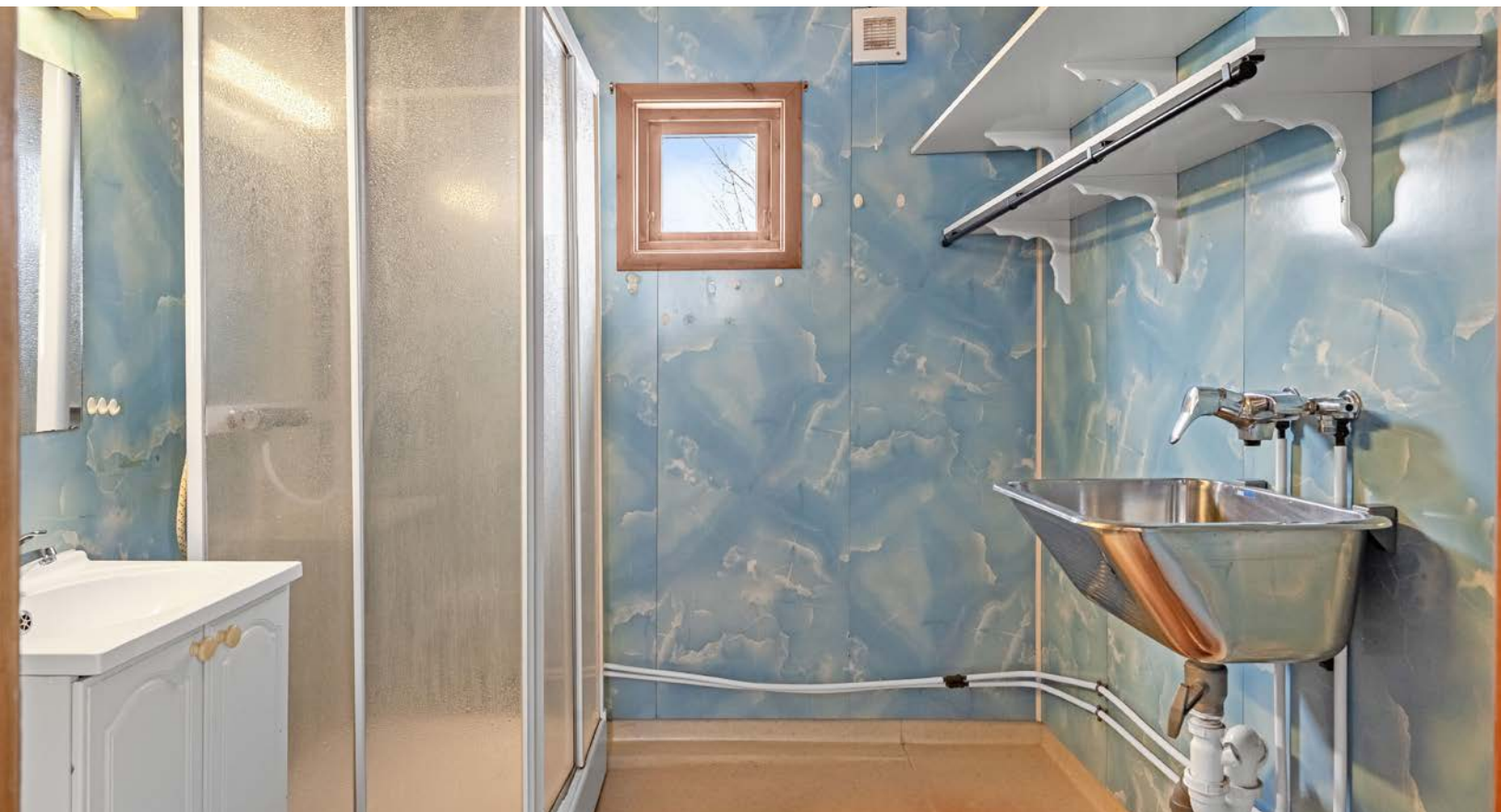
Bad/vaskerom fra 1980-tallet med våtromsbelegg på gulv, elektriske varmekabler, våtromsplater på veggene og elektrisk vifte.
