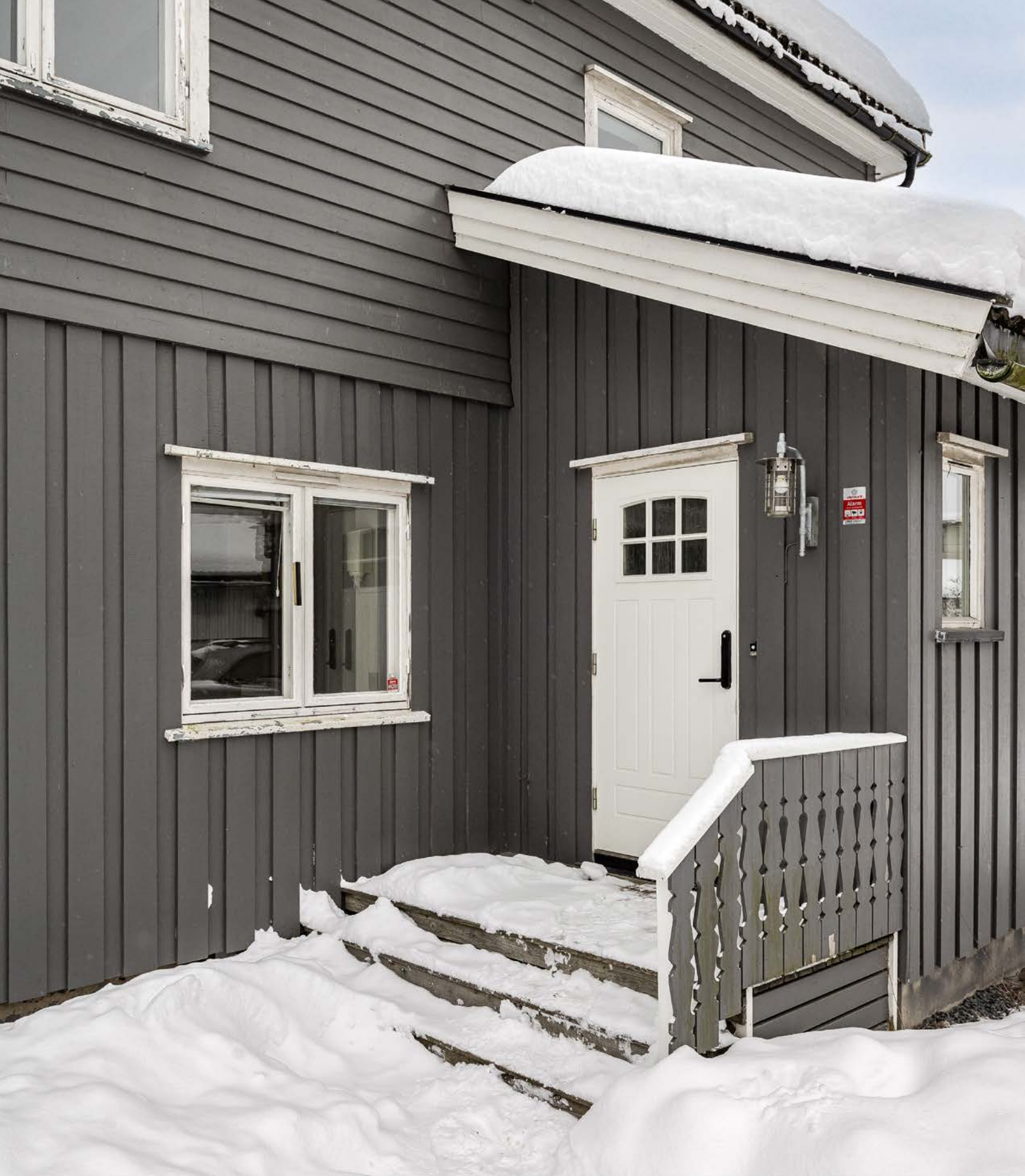
Boligen ble tilbygget med entré og bad i 1987. Praktisk med kodelås montert på ytterdøren og utebelysning på vegg.
