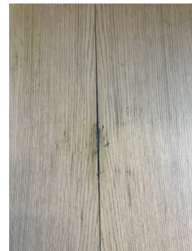
Eldre fuktmerke i parkettgulv, ingen fukt registrert
