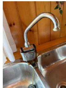
Vannkran på kjøkken er tapet over.
