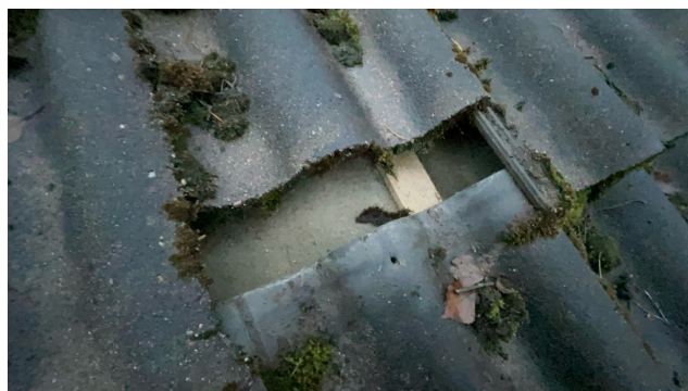
Kontroll av undertak.
