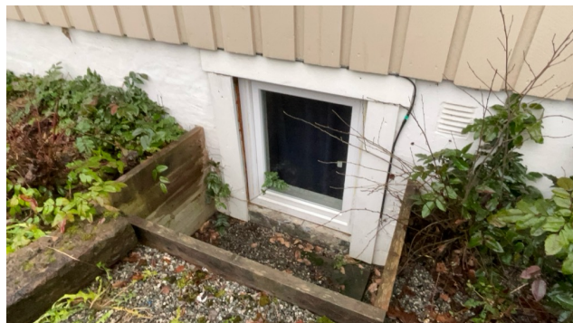
Blikk og belistning bør utbedres.
