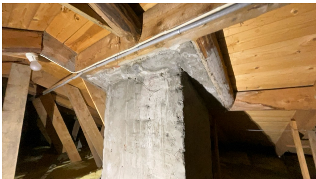
Kontroll rundt pipeløp.
