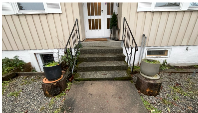
Besiktigelse av trapp.
