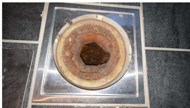
Kontroll av sluk.
