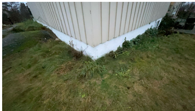
Kontroll av drenering/fuktsikring.
