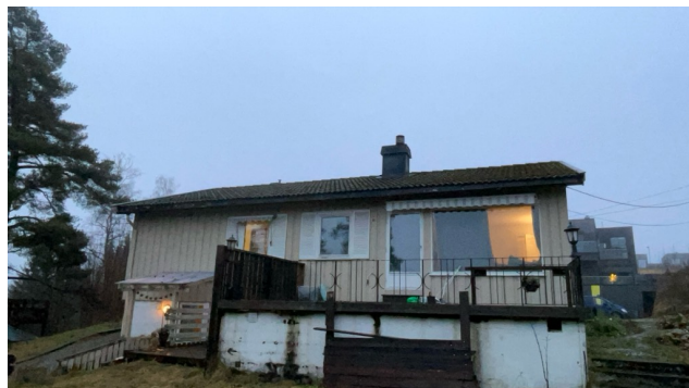
Besiktigelse av taktekke.
