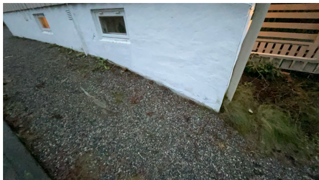
Kontroll av drenering/fuktsikring.
