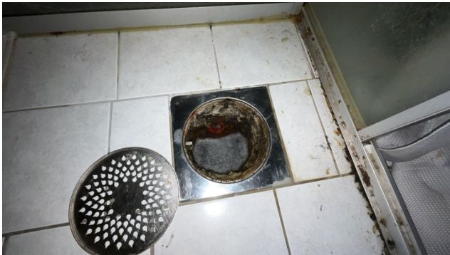
Kontroll av sluk.
