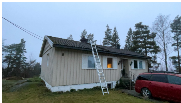
Besiktigelse av taktekke.
