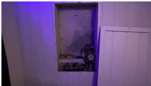
Besiktigelse av røropplegg. Stoppekran er plassert i vegg på alkove.
