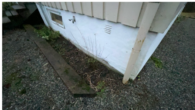
Kontroll av drenering/fuktsikring.
