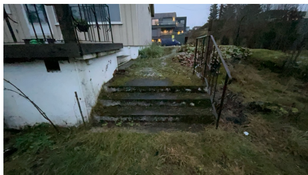
Besiktigelse av trapp.
