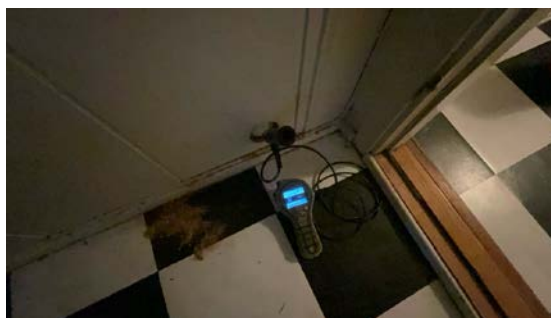
Utført hulltaking på rom under terreng.
