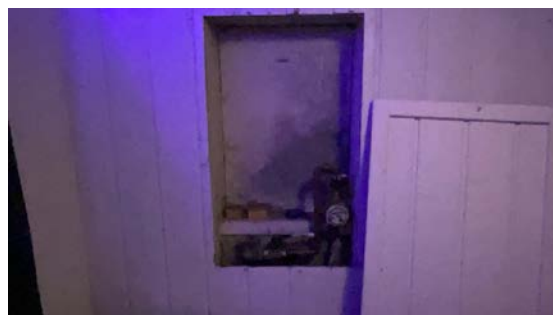
Besiktigelse av rørøpplagg. Stoppekran er plassert i vegg på alkove.
