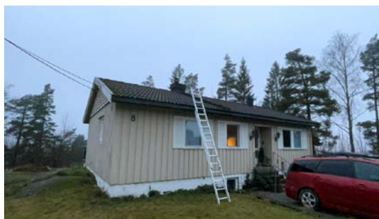
Besiktigelse av taktekke.
