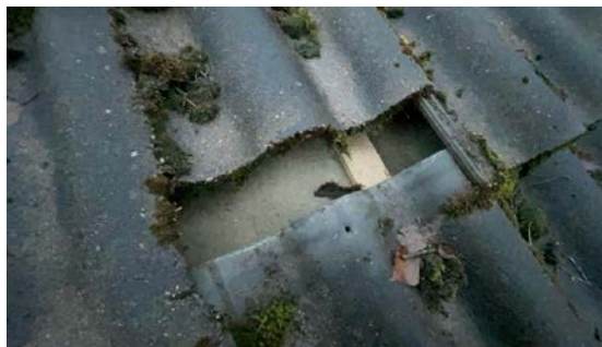
Kontroll av undertak.
