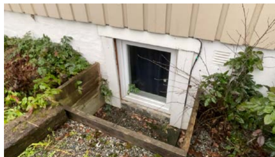
Blikk og belistning bør utbedres.
