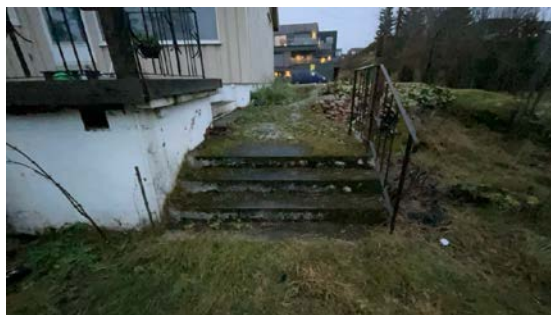
Besiktigelse av trapp.
