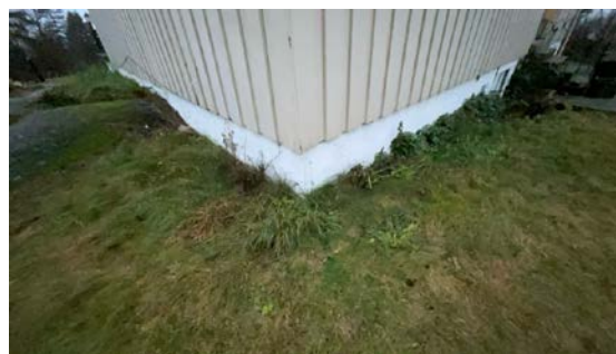
Kontroll av drenering/fuktsikring.
