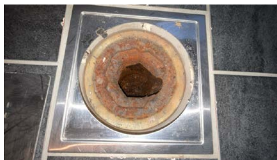
Kontroll av sluk.
