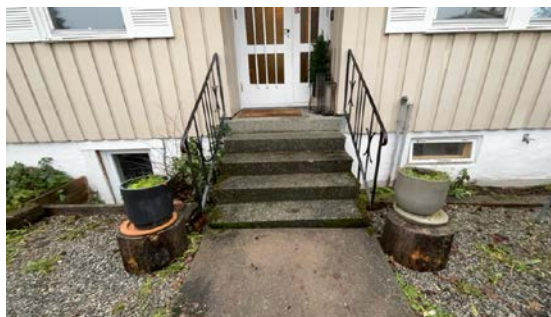
Besiktigelse av trapp.
