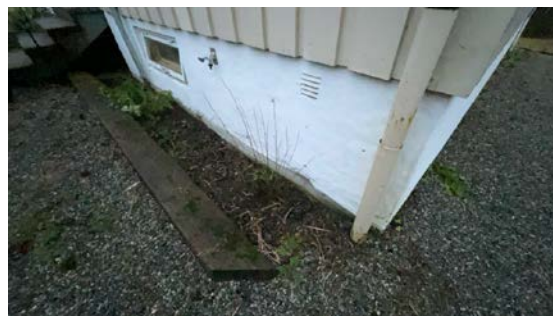
Kontroll av drenering/fuktsikring.
