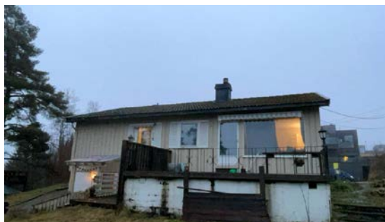
Besiktigelse av taktekke.
