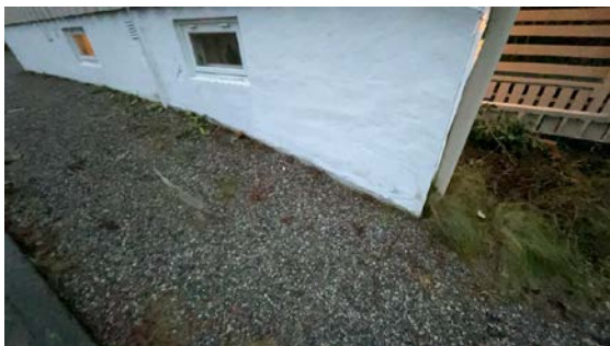
Kontroll av drenering/fuktsikring.
