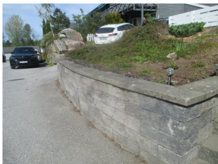
Forstøtningsmur mot vei.
