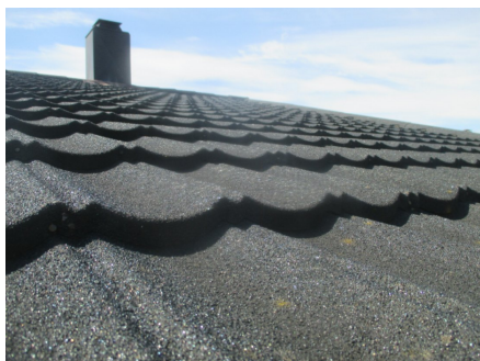
Deler av taktekkinge
