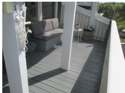
Deler av større terrasse ut i fra stue.
