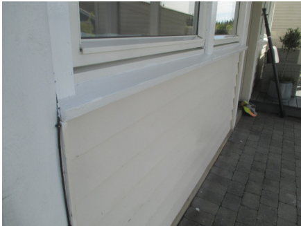
Deler av kledningen med tilhørende belistninger.
