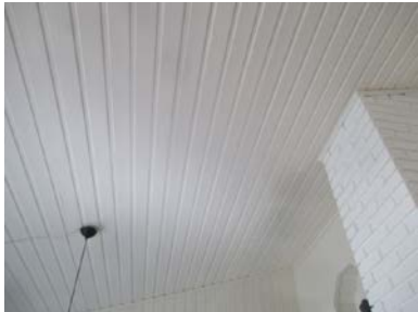
Hele takkonstruksjonen er en lukket konstruksjon
