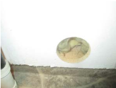
Hulltaking fra vaskerommet
