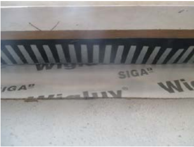
Bakveggen er kledd og luftet på nytt
