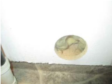
Hulltaking i vegg mot bad.
