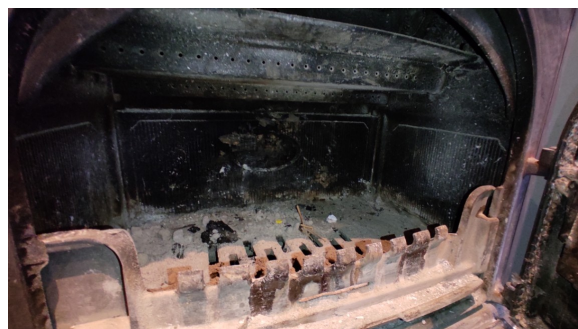
Kontroll av ildsted.
