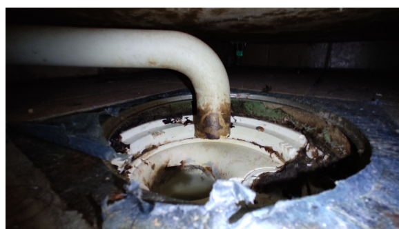
Kontroll av sluk.
