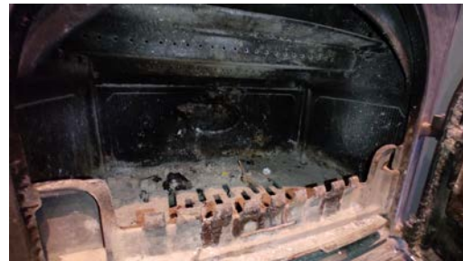
Kontroll av ildsted.
