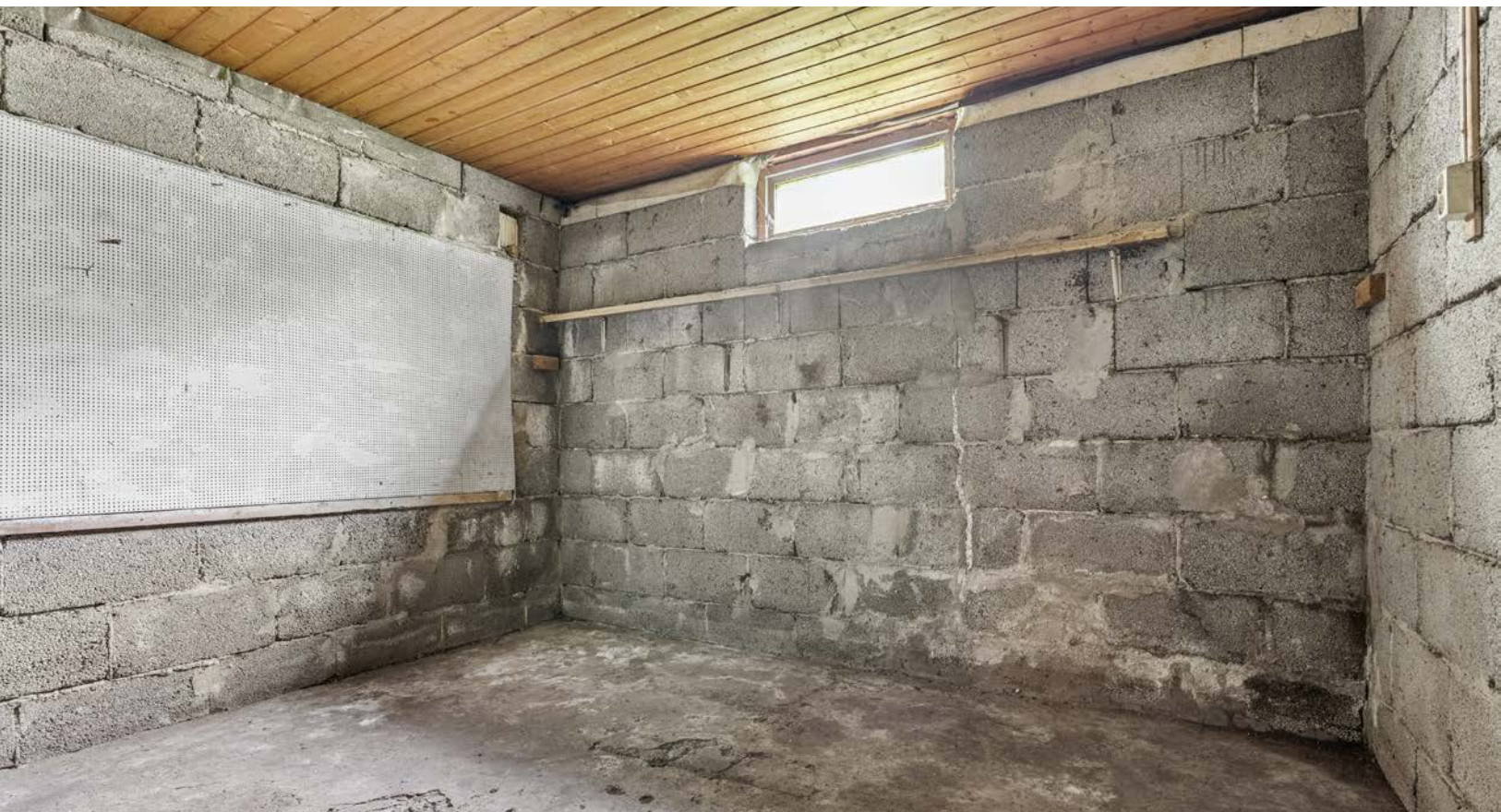
Uinnredet rom i kjeller
