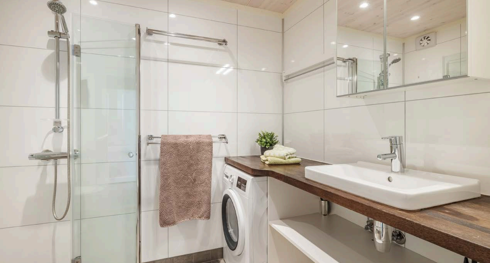
Lyst og moderne baderom fra byggeåret 2017. Badet rommet har flislagt gulv med gulvvarme, lyse våtromsplater på veggene, downlights i himlingen og avtrekksvifte.
