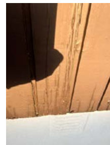
Kledning montert helt ned på vannbrett over vindu.
