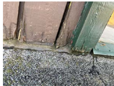
Liten oppkant, overgang tak/vegg
