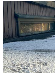
Kledning montert helt ned på vannbrett over vindu.
