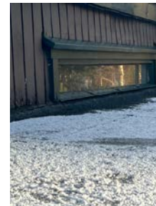
Lav oppbrett på takteking under vinduet.
