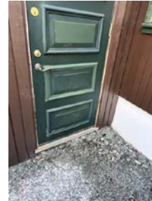
Noe malingsslitt overflate på bør til carport
