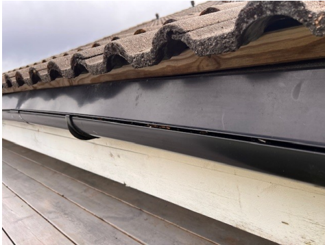
Bordtaks beslag mangler.
