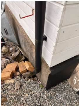
Takvann slippes på grunn og terrasse
