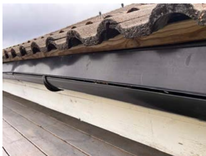
Bordtaks beslag mangler.
