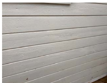
Råteskade i kledning på fasade sør/vest
