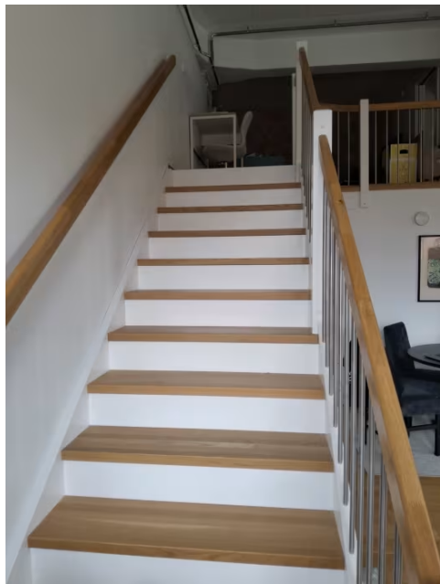
Lukket tretrapp mellom første etasje og hems.
