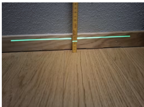
Etasjeskille er kontrollert med nivelleringslaser.
