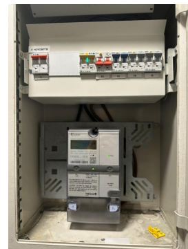
Sikringssskap med automatsikringer.
