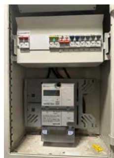
Sikringskap med automatsikringer.
