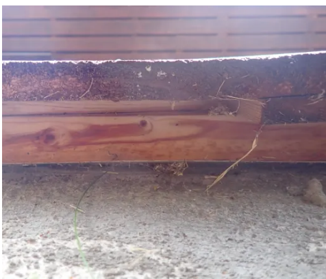
Oversikt oppunder kledning.
