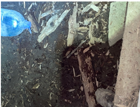
Råteskadet treverk
