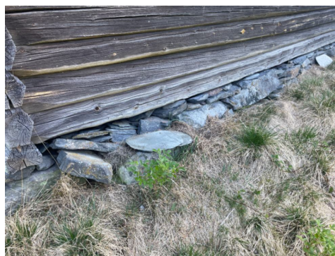
Ringmur av natursteinsmur
