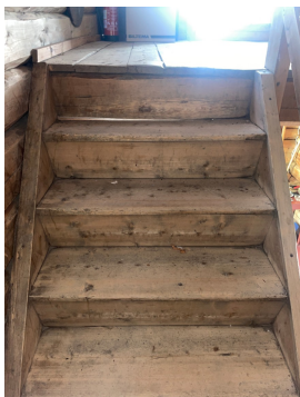
Skeivheter i trinn og noe bevegelse/knirk
