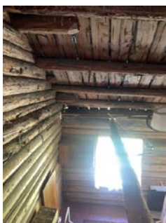
Lysglipper i takteking og synlig nedbøyning/skeivheter.
