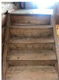
Skeivheter i trinn og noe bevegelse/knirk
