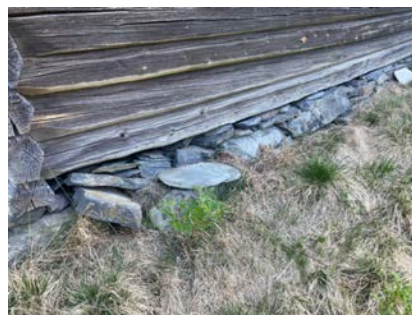
Ringmur av natursteinsmur
