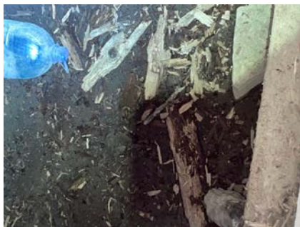
Råteskadet treverk
