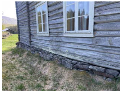
Ringmur av natursteinsmur
