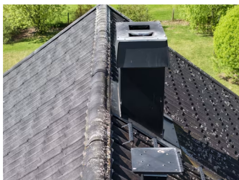
Pipe over tak er inspisert med drone.
