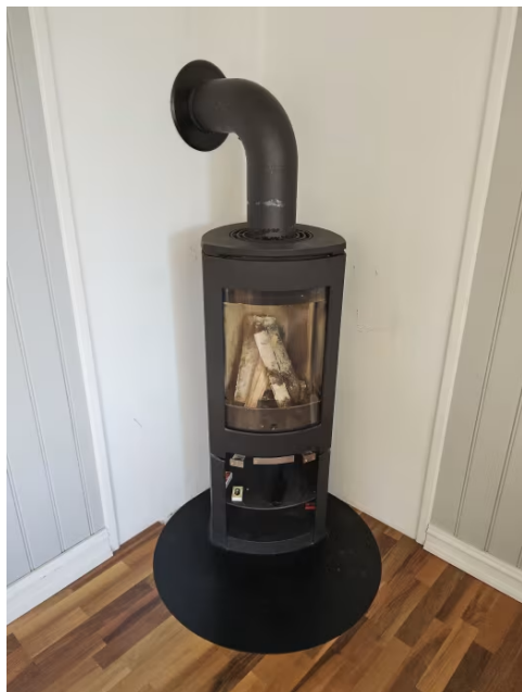
Vedovn med glassdør i stue.
