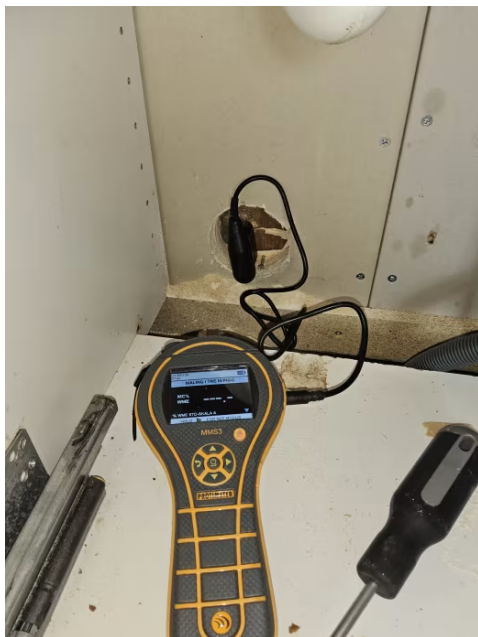
Bilde fra fuktmåling i veggkonstruksjon tilstøtende våtsone.
