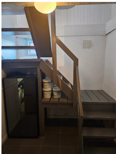
Trapp mellom 1. etasje og kjelleretasje.
