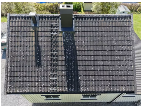
Det er etablert takstige til pipe.
