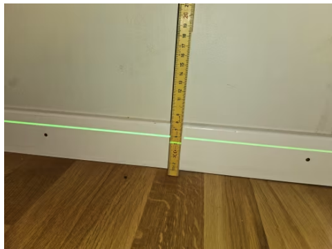
Etasjeskiller er kontrollert med nivelleringslaser.
