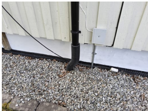
Boligen har grunnmur av betong med sparestein.
