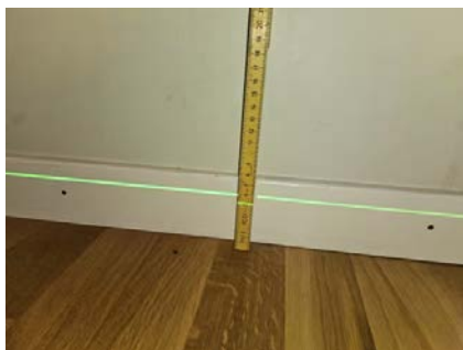
Etasjeskiller er kontrollert med nivelleringslaser.
