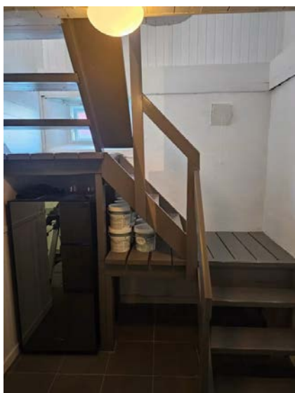
Trapp mellom 1. etasje og kjelleretasje.
