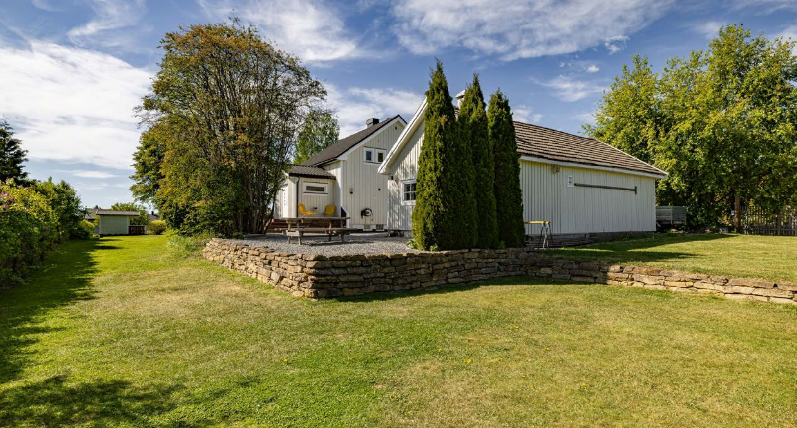
Gruset uteplass opparbeidet med støttemur mot hagen.
