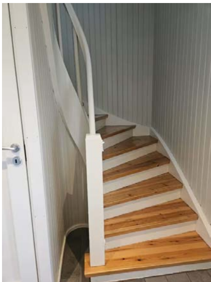
Trapp mellom 1. etasje og loftsetasje.
