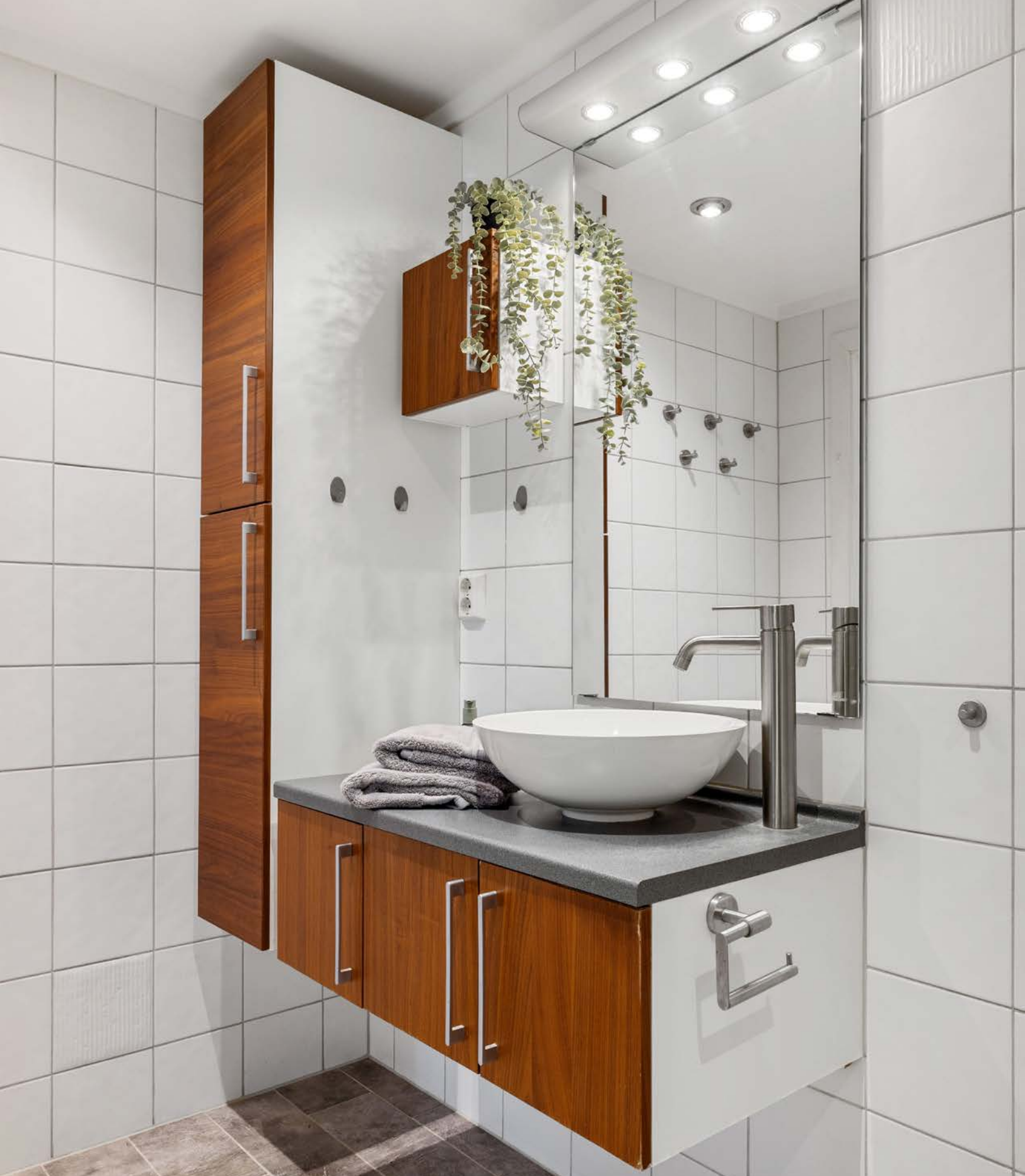
Baderomsinnredning med veggskap, benkeplate og toppmontert servant. I overkant av servanten er det speil med lys og elektrisk uttak.
