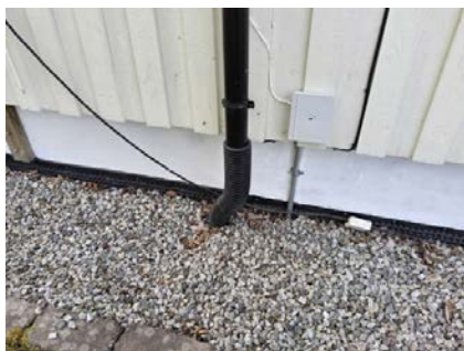
Boligen har grunnmur av betong med sparestein.
