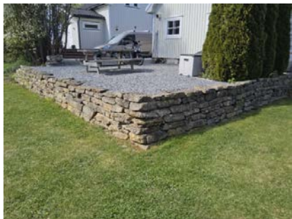
Støttemur i naturstein.
