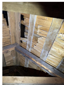
Synlig papp i møne ligger ikke med overlapp over undertakstekkingen.
