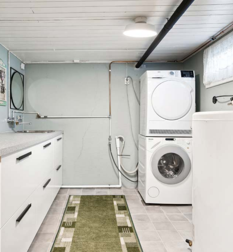
Vaskerom med opplegg for vaskemaskin, her er også varmtvannsberederen plassert.
