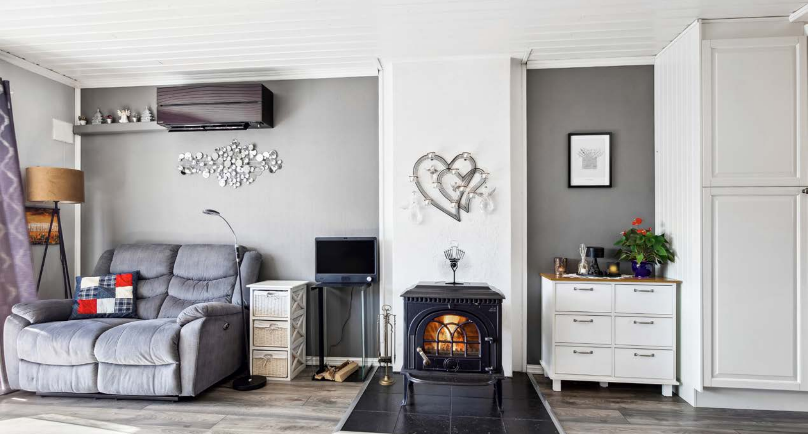
Gode oppvarmingskilder i stue som vedovn og varmepumpe.
