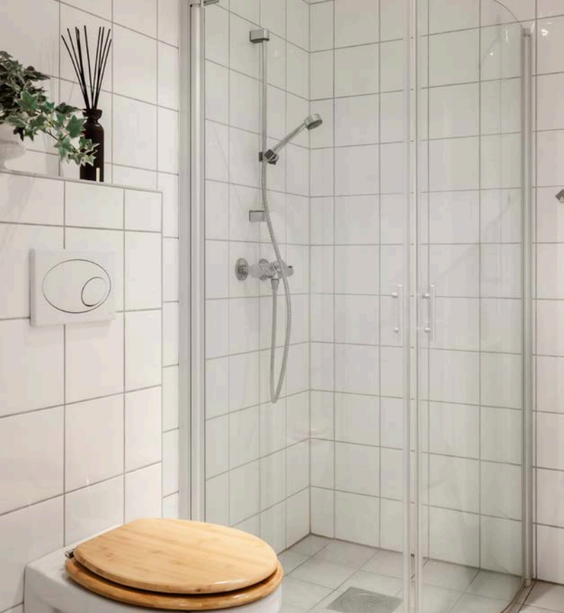
Dusjhjørne med innfellbare glassvegger og vegghengt dusjarmatur.
