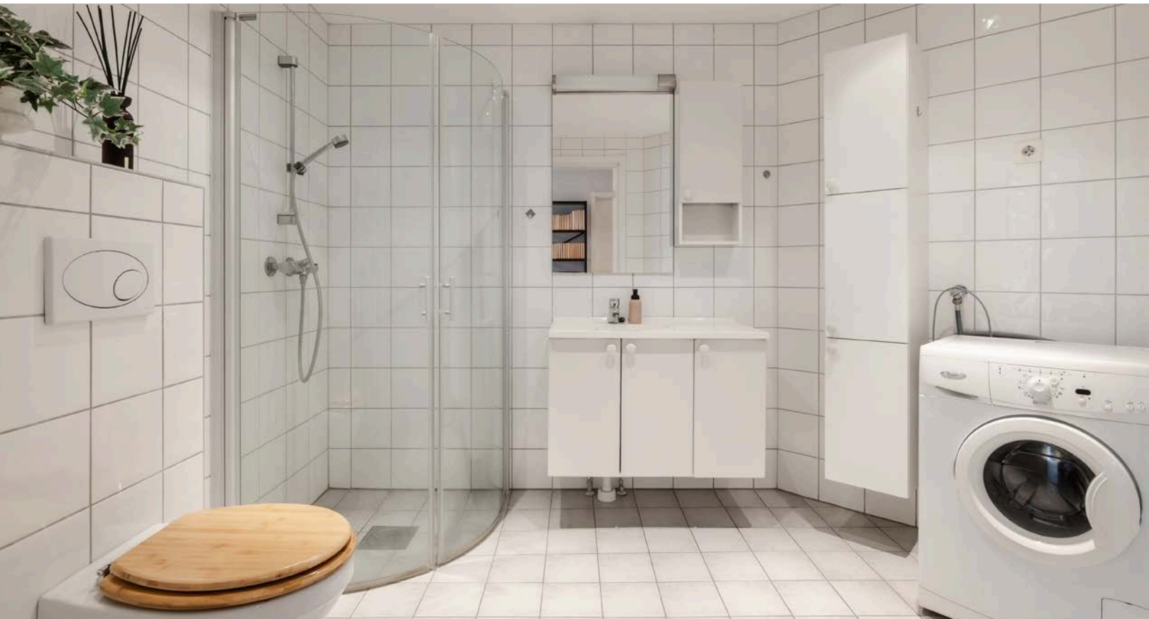
Badet har flislagte vegger og gulv med elektriske varmekabler. Det er utstyrt med veggmontert toalett.
