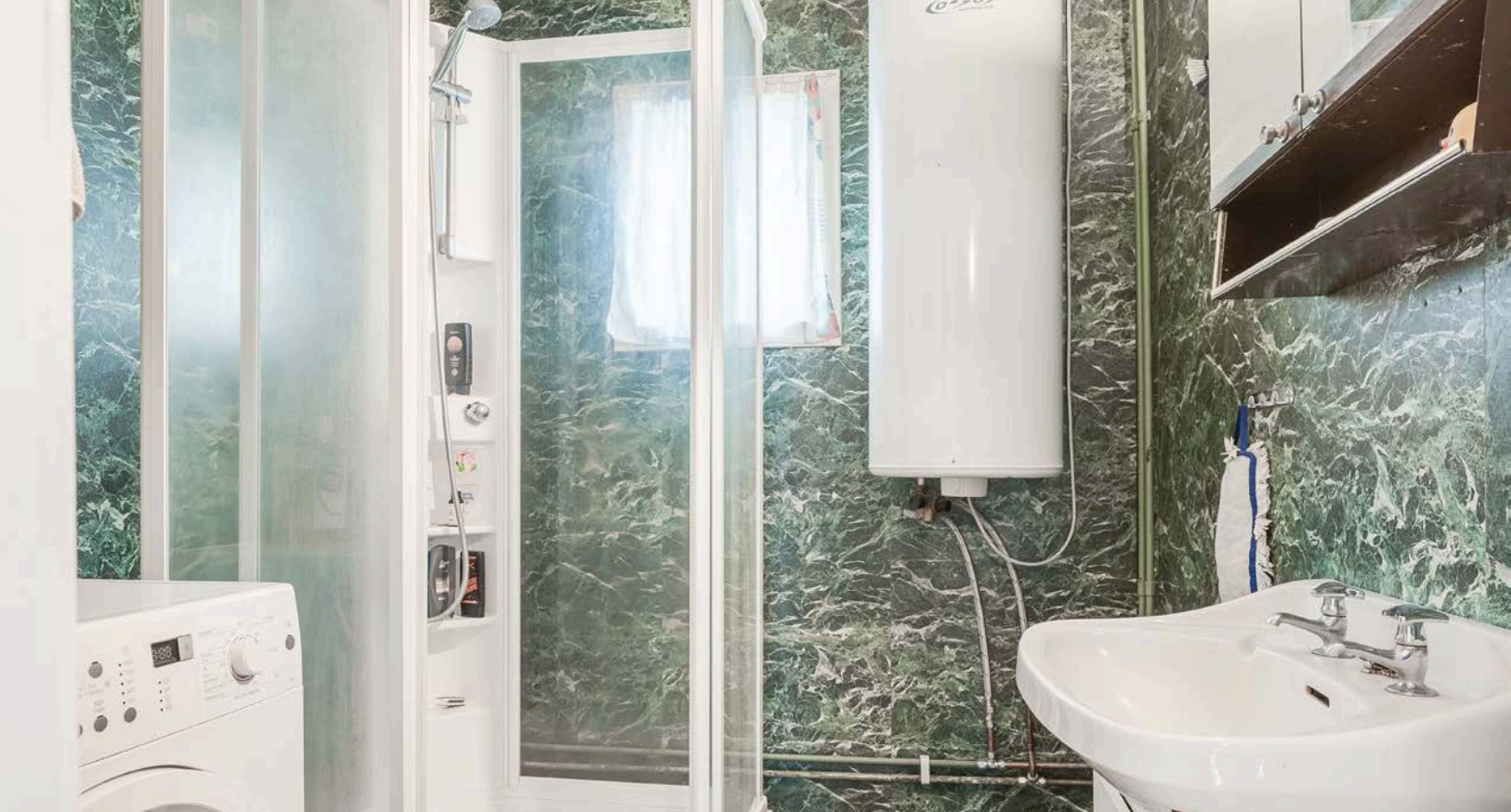
Eldre bad/vaskerom i leiligheten i 2. etasje med våtromsbelegg på gulv og våtromsplater på veggene.
