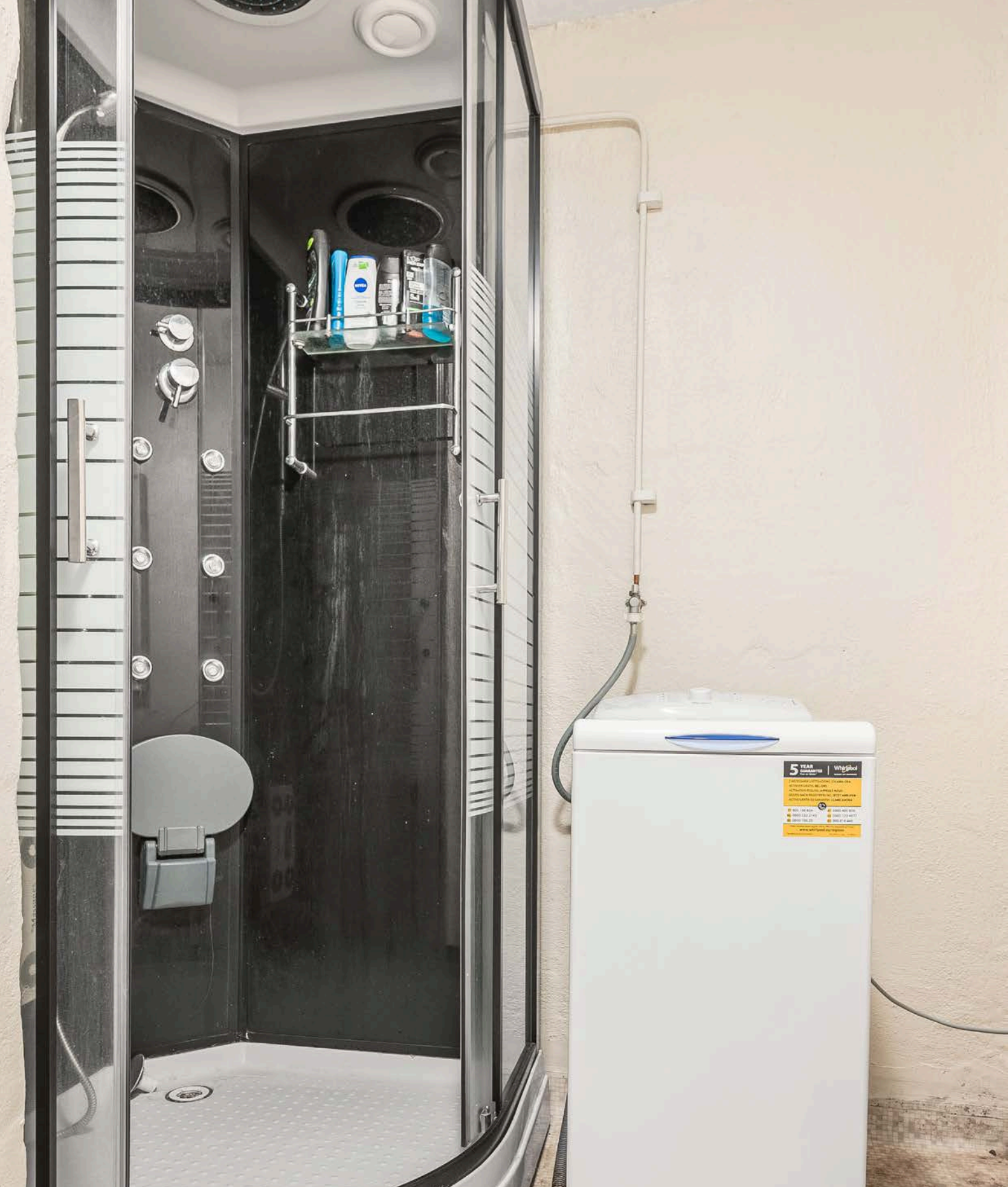
Eldre Bad/vaskerom i kjeller med våtromsbelegg på gulv og overflater med malt murpuss. Rommet er utstyrt med dusjkabinett og opplegg for vaskemaskin.
