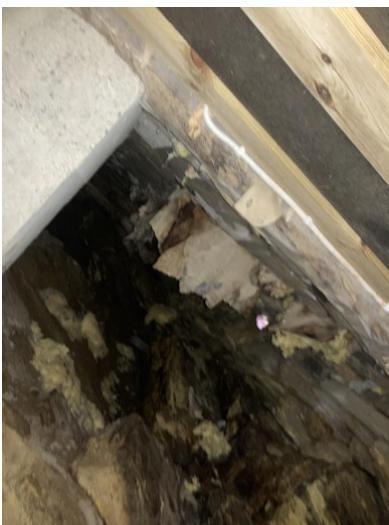
Bilde av krypkjeller.
