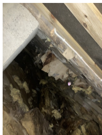
Bilde av krypkjeller.
