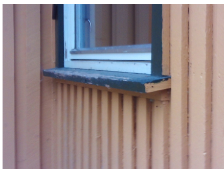
Deler av kledningen med tilhørende belistninger.
