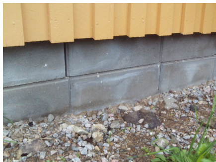
Ringmur av betongblokker på tilbygget del.
