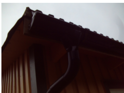
Takrenner og nedløp av stål på tilbygget.
