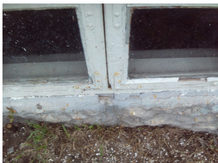
Slitte/skadet kjellervinduer
