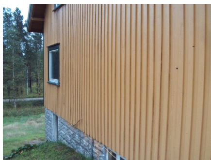
Deler av ene fasaden.
