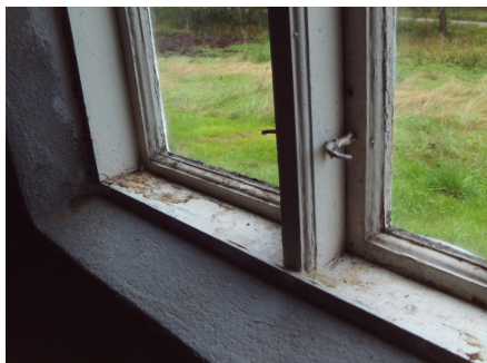
Kjellervinduer med enkle glass.
