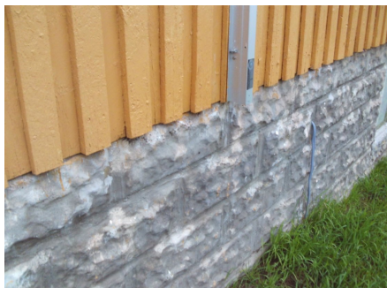
Deler av grunnmur i rundt opprinnelig del.
