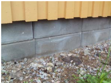
Ringmur av betongblokker på tilbygget del.
