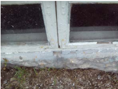
Slitte/skadet kjellervinduer
