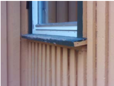
Deler av kledningen med tilhørende belistninger.
