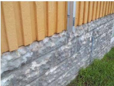
Deler av grunnmur i rundt opprinnelig del.
