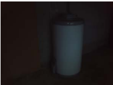
Bereder er plassert i grovkjeller
