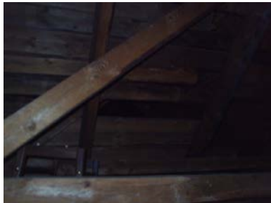
Sperrekonstruksjon med bord som undertak
