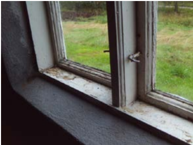
Kjellervinduer med enkle glass.
