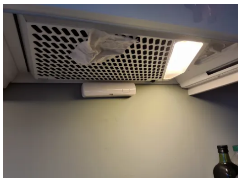
Avtrekkseffekten er testet med papir.
