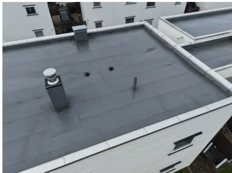
Taktekking av PVC-basert takmembran.
