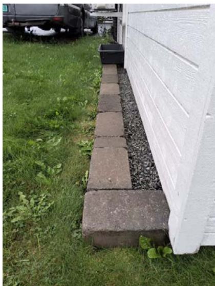
Grøft med drenerende masser.
