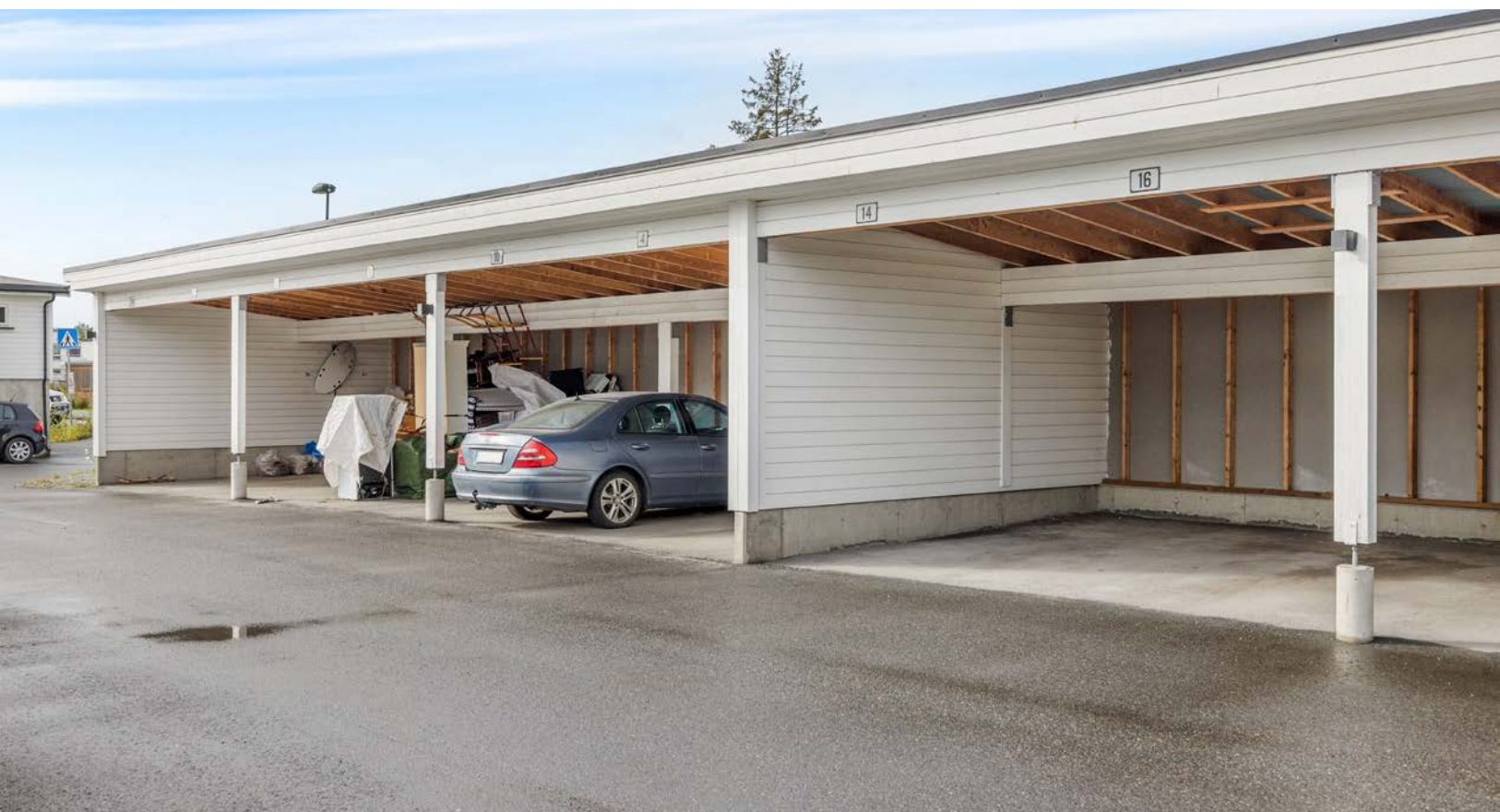
Biloppstillingsplass i felles carportanlegg følger leiligheten.
