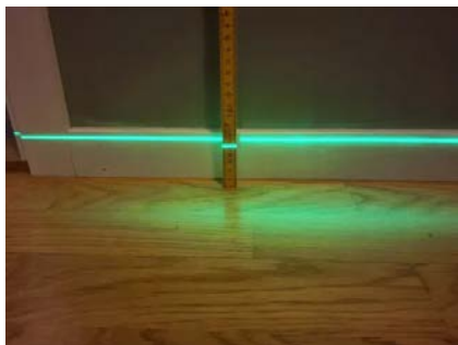
Etasjeskille er kontrollert.
