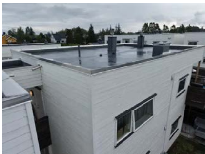
Boligen har flatt tak med parapet.
