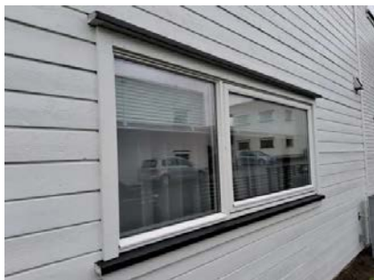
Boligen har vinduer med karmen av tre med tre-lags glass.
