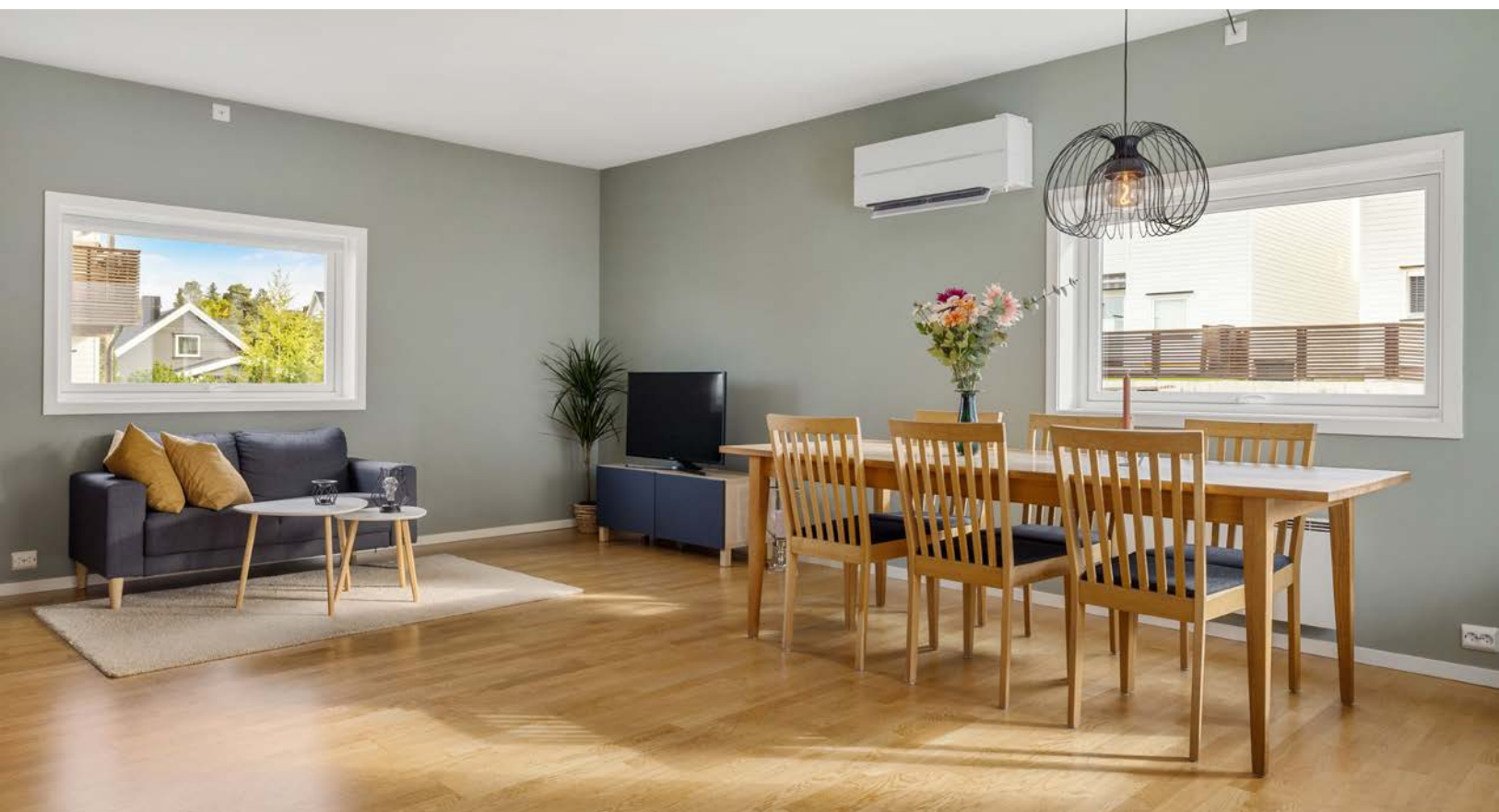
Det er montert varmepumpe i 2023 som sørger for jevn og god varme i leiligheten.
