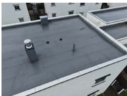
Taktekking av PVC-basert takmembran.
