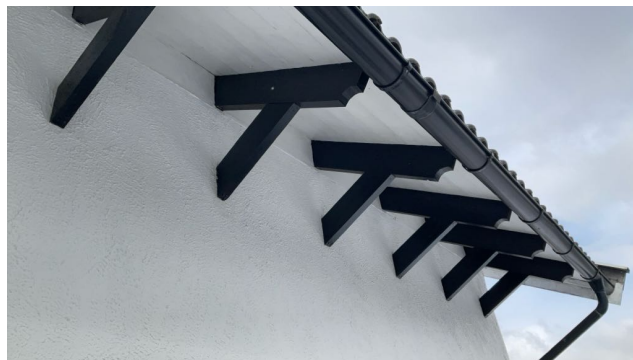
Gesims på opprinnelig del.
