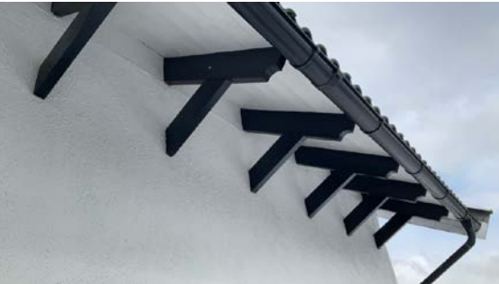
Gesims på opprinnelig del.
