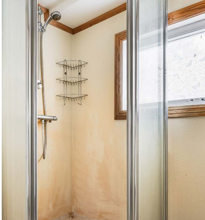
Badet er i dag innredet med toalett, servant på innredning og dusjkabinett.
