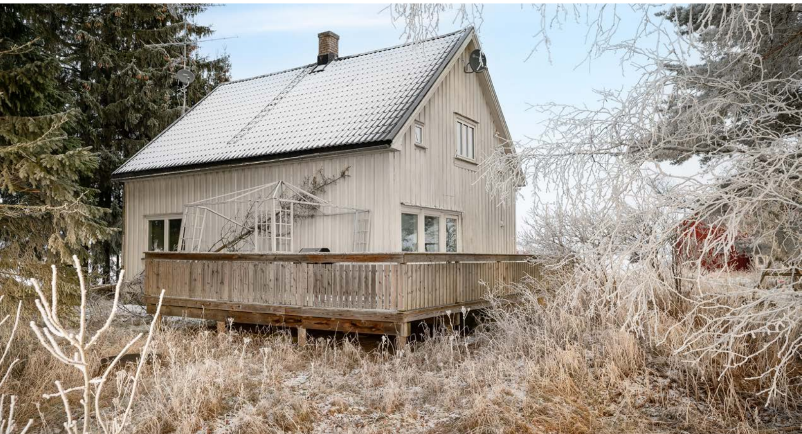
Terrasse rundt store deler av boligen.
