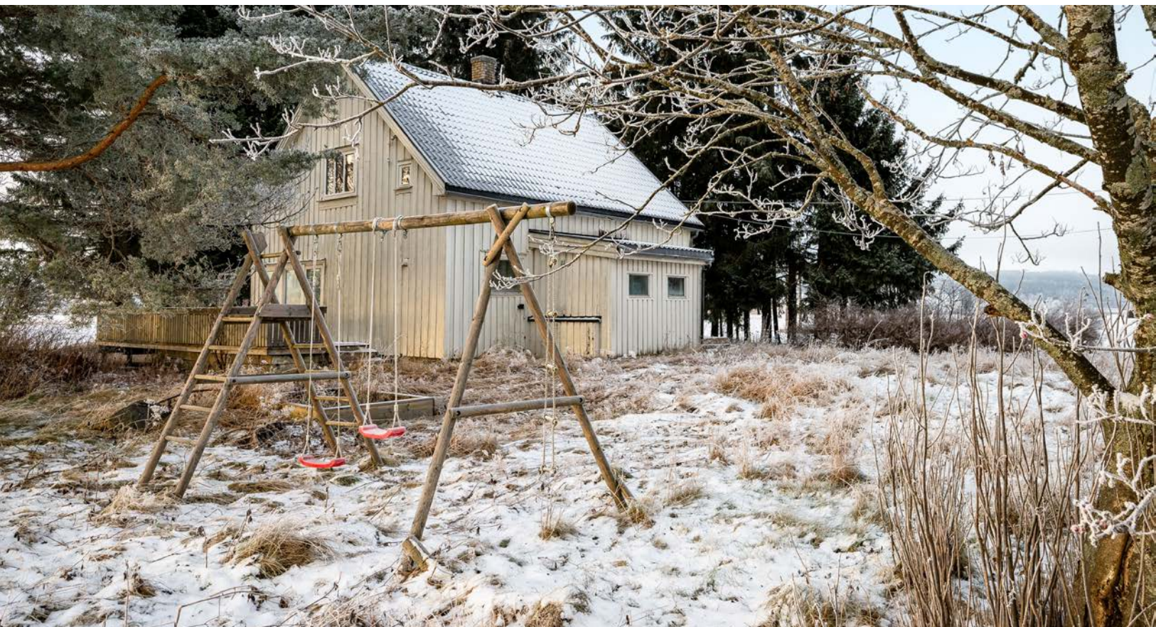
Tomten bærer preg av manglende vedlikehold, men har mye potensiale.
