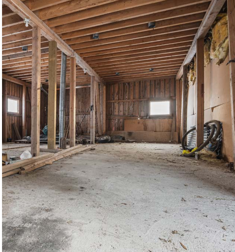
Inne i driftsbygningen.
