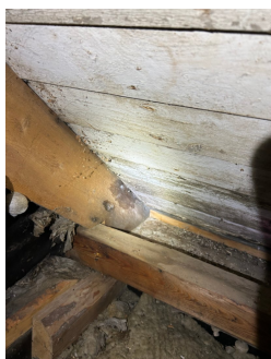
Misfarget undertak i blindkott og manglende lufting nederst på taket.
