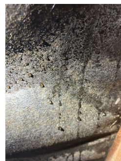
Synlig vann/kondens på veggflate i blindkott.
