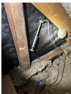
Misfarget undertak i blindkott og manglende lufting nederst på taket.
