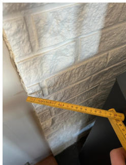
For liten avstand til brennbart materiale.
