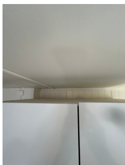
For liten avstand til brennbart materiale.
