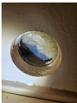
Måling av RF i lukket veggkonstruksjon.
