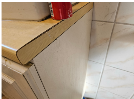
Fuktskadet innredning.
