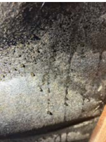
Synlig vann/kondens på veggflate i blindkott.
