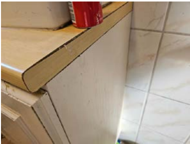
Fuktskadet innredning.
