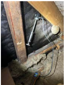
Misfarget undertak i blindkott og manglende lufting nederst på taket.
