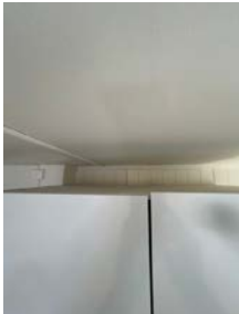
For liten avstand til brennbart materiale.
