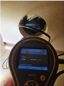
Måling av trefukt i lukket veggkonstruksjon.
