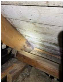
Misfarget undertak i blindkott og manglende lufting nederst på taket.
