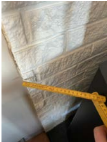
For liten avstand til brennbart materiale.
