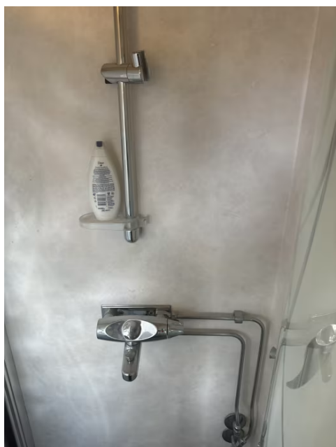
Det er ikke montert dusjgarnityr
