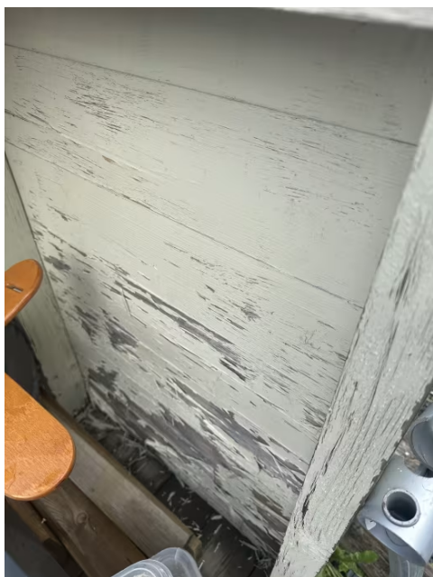
Maling flasser på rekkverk på terrasse
