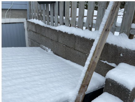
Bod plassert foran støttemur.
