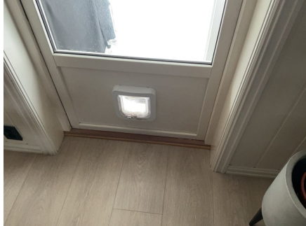
Balkongdør med katteluke
