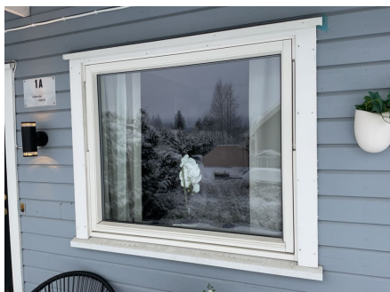
Vindu på soverom er byttet i 2019.
