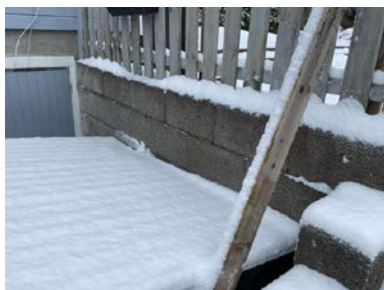
Bod plassert foran støttemur.
