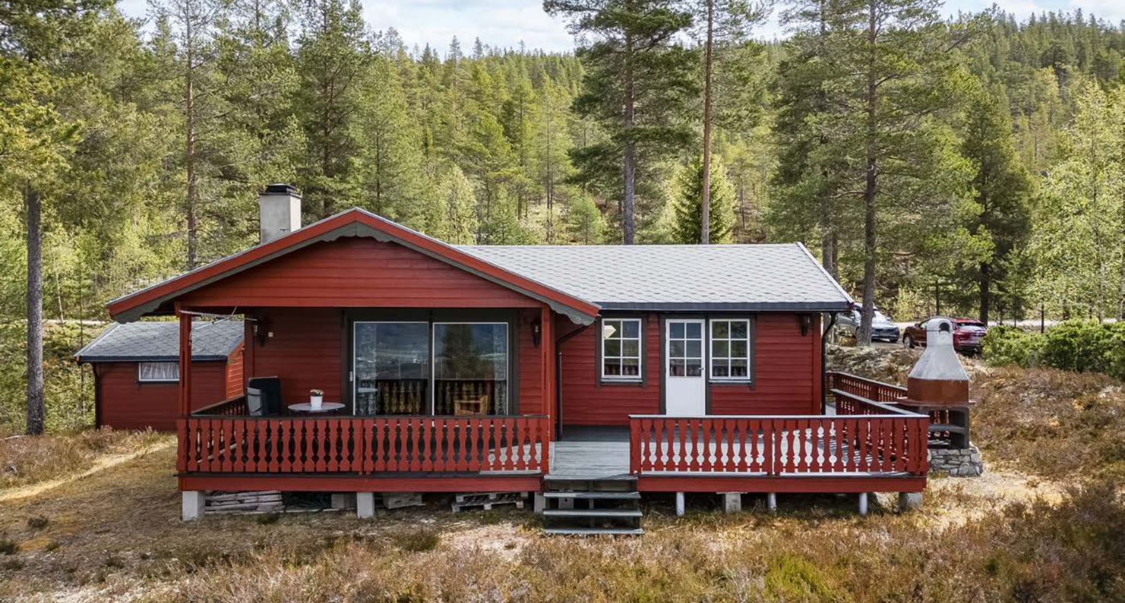
Vedlikeholdt hytte som ble overflatebehandlet med to strøk i 2023, samt oppgradert med nytt tak i 2010.
