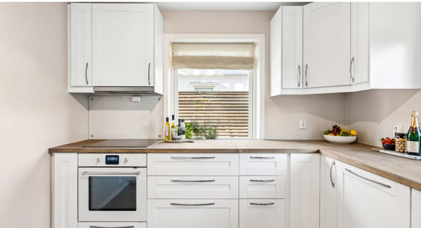
Innredningen har klassiske, profilerte fronter i malt MDF og benkeplate i heltre
