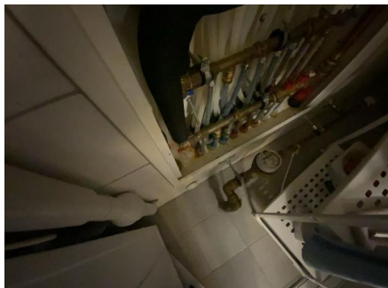
Stoppekran montert inne på Vaskerom/bad
