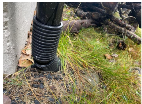
Brudd i drensledning ved grunnmur
