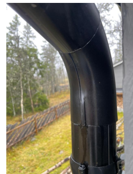
Brudd i drensledning ved grunnmur
