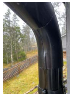
Brudd i drenerledning ved grunnmur
