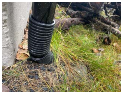
Brudd i drenerledning ved grunnmur
