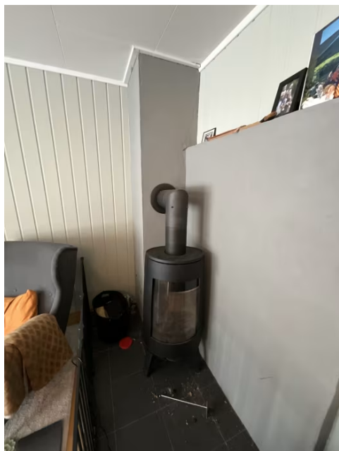
Viser ildsted plassert i stue 1. etaje
