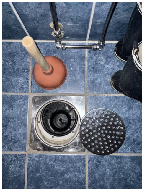
Viser sluk i dusjsonen.
