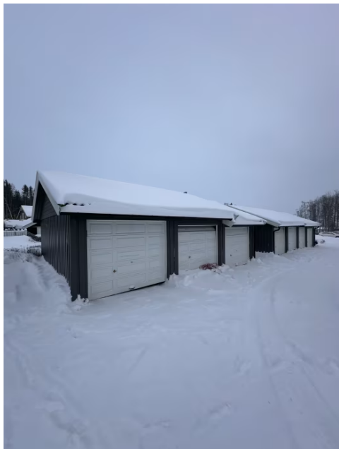
Viser garasjeplass i felles garasjeanlegg. Port nr 2 fra venstre.
