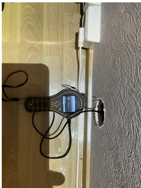
Det er foretatt hulltaking med 73 mm hullbor fra tilstøtende rom (bod).
