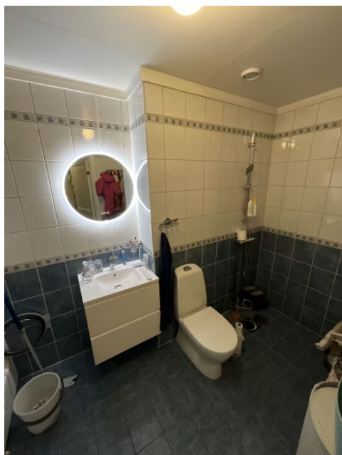
Viser dusjsonen, gulvstående toalett og baderomsinnredning.
