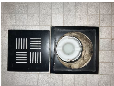
Viser sluk i dusjsonen.
