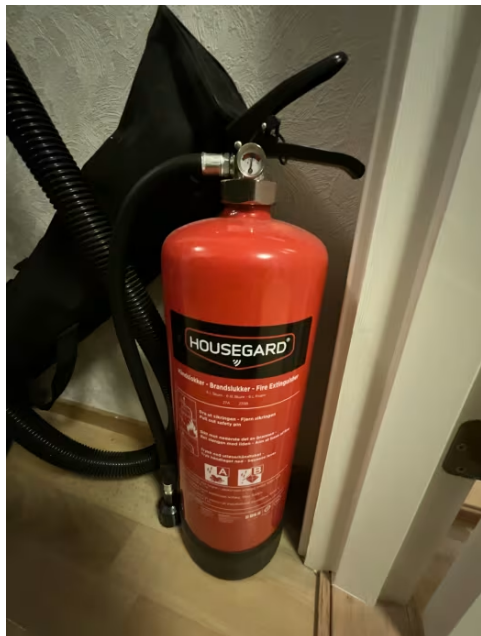
Viser brannslukningsapparat plassert i 2.etasje
